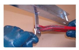
Pressen Sie mit einer Zange oder ähnlichem die Bandschelle etwas in Form! Verfahren Sie so auch mit der 2. Bandschelle!
