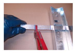
Setzen Sie an der ersten Markierung eine Zange oder ähnliches an und biegen Sie Bandschelle nach oben (ca. 90°)!
