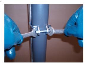
Verschrauben Sie die Schellen mit den mitgelieferten Sechskantschrauben und Muttern! Verwenden Sie dazu z.B. 2 Maulschlüssel mit der Schlüsselweite 13 mm oder ähnliches!
