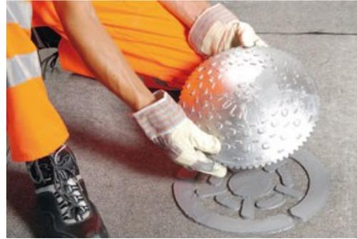
Der Kölner Teller wird nur mit dem Rand und den Stützrippen im Kleber verlegt. Eine **vertikale** Noppenmarkierung weist auf die darunterliegende Stützrippe hin. Die 6 mm-Bohrung dient als Entlüftung, nicht als Markierungszeichen.
